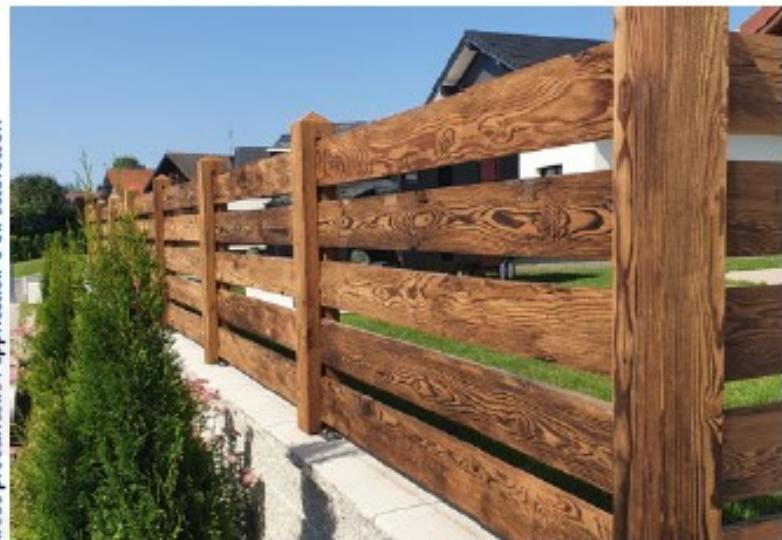
En pose extérieure, pour optimiser le maintien de la couleur, nous préconisons l'application d'un saturateur.
